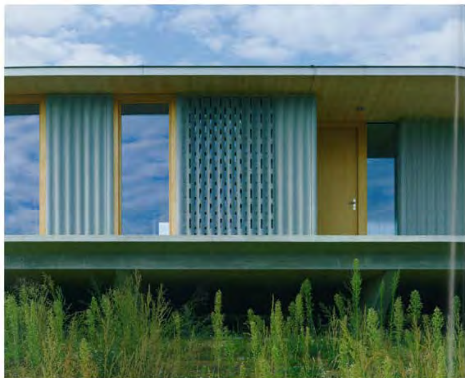
Des plaques ondulées de fibre de ciment alternant surfaces pleines et ajourées rythment la façade.
